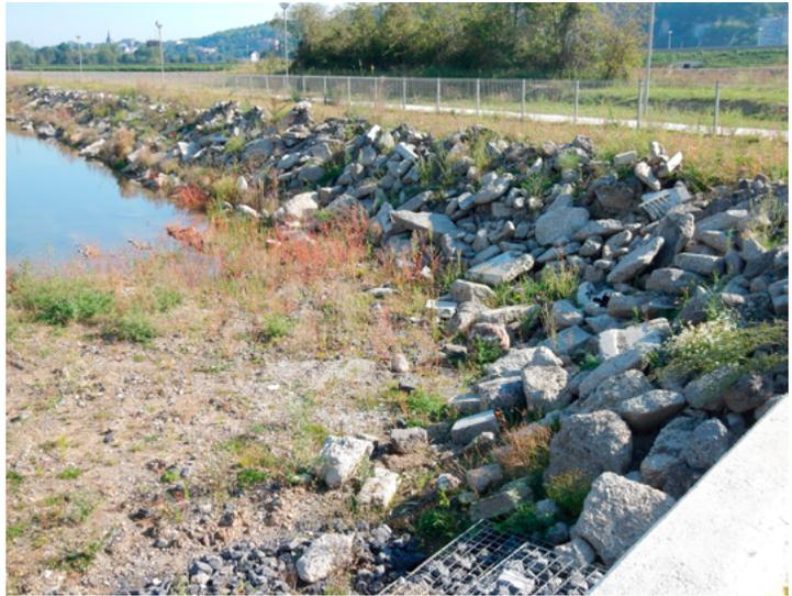
Photo 21 : la zone de battement des eaux des bassins d'orage peut être aménagée à l'attention des amphibiens. Des dispositifs enherbés comme celui-ci présentent peu d'intérêt.
