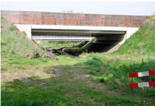
Photo 13 : un passage à faune multi-spécifique peut-être très efficace pour préserver la connectivité entre les populations à l'échelle des paysages. De tels passages peuvent notamment être installés lorsque des routes à grand gabarit croisent des cours d'eau.
