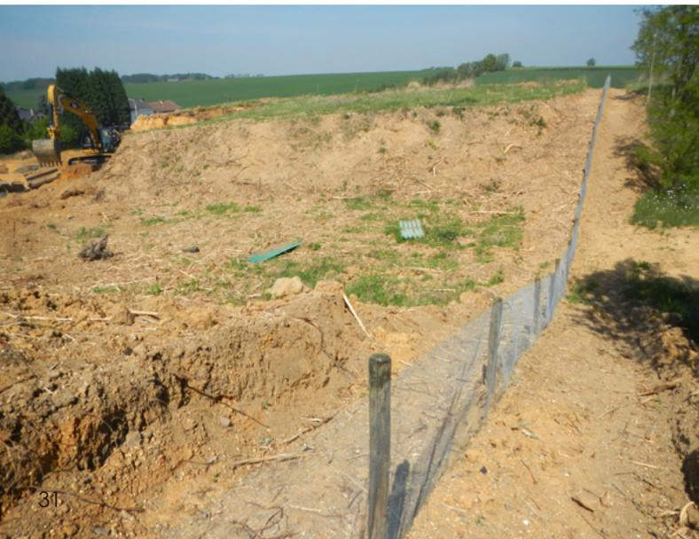
Photo 7 : clôture destinée à empêcher l'accès des amphibiens à une zone en voie d'être remaniée.
