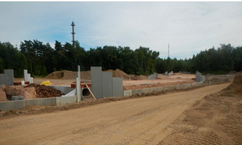
Photo 12 : création d'un crapauduc à plusieurs tunnels sous une nouvelle voirie.
