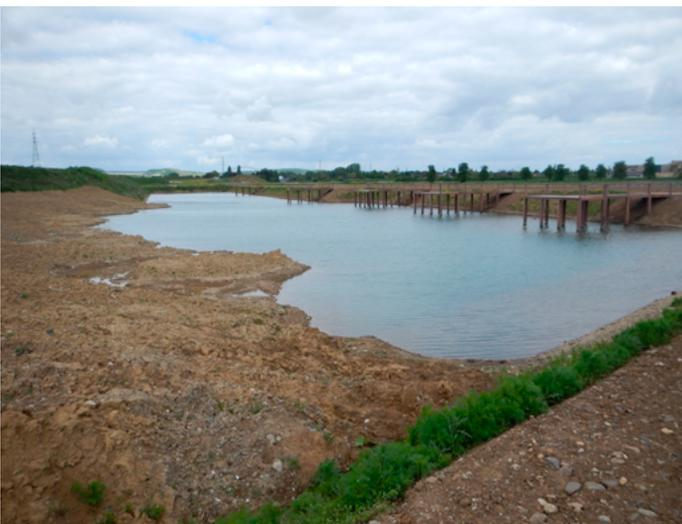
Photo 26 : une surveillance attentive des niveaux d'eau pendant une année permet d'éviter les erreurs d'aménagement des berges des plans d'eau liées à des niveaux d'eau inattendus.
