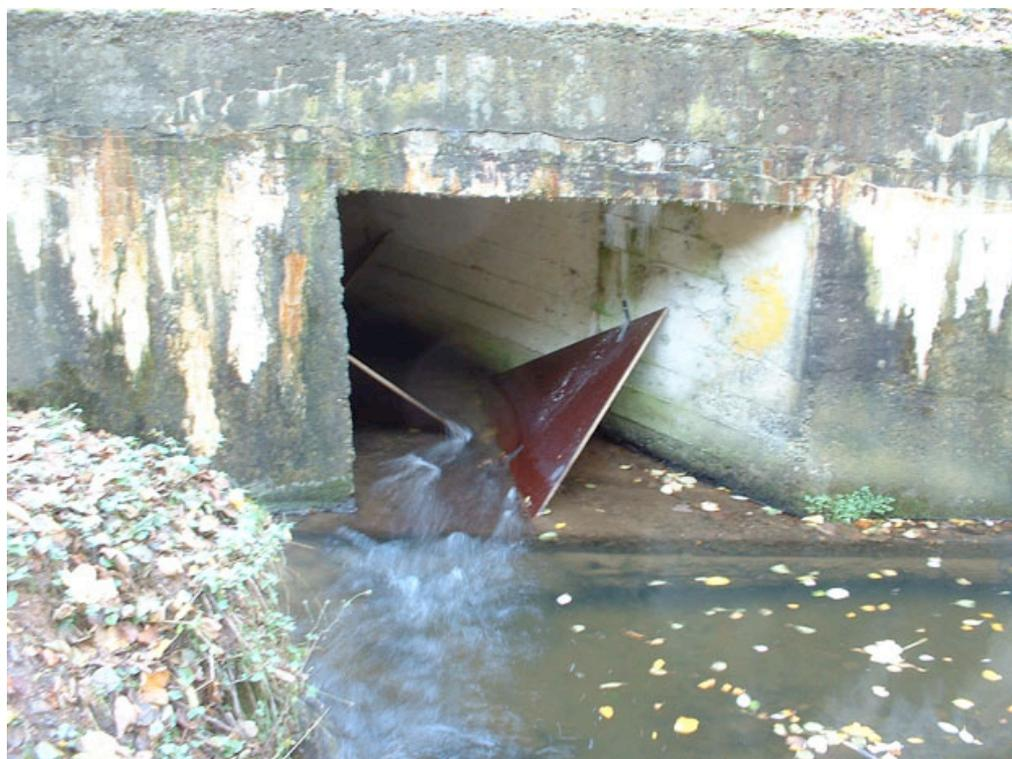
Photo 44. Placement de déflecteurs dans un passage sous-routier sur un petit affluent de l'Ourthe (R. de Floumont) pour faciliter la remontée des poissons et spécialement des truites (photo A. Lamotte, SP).
