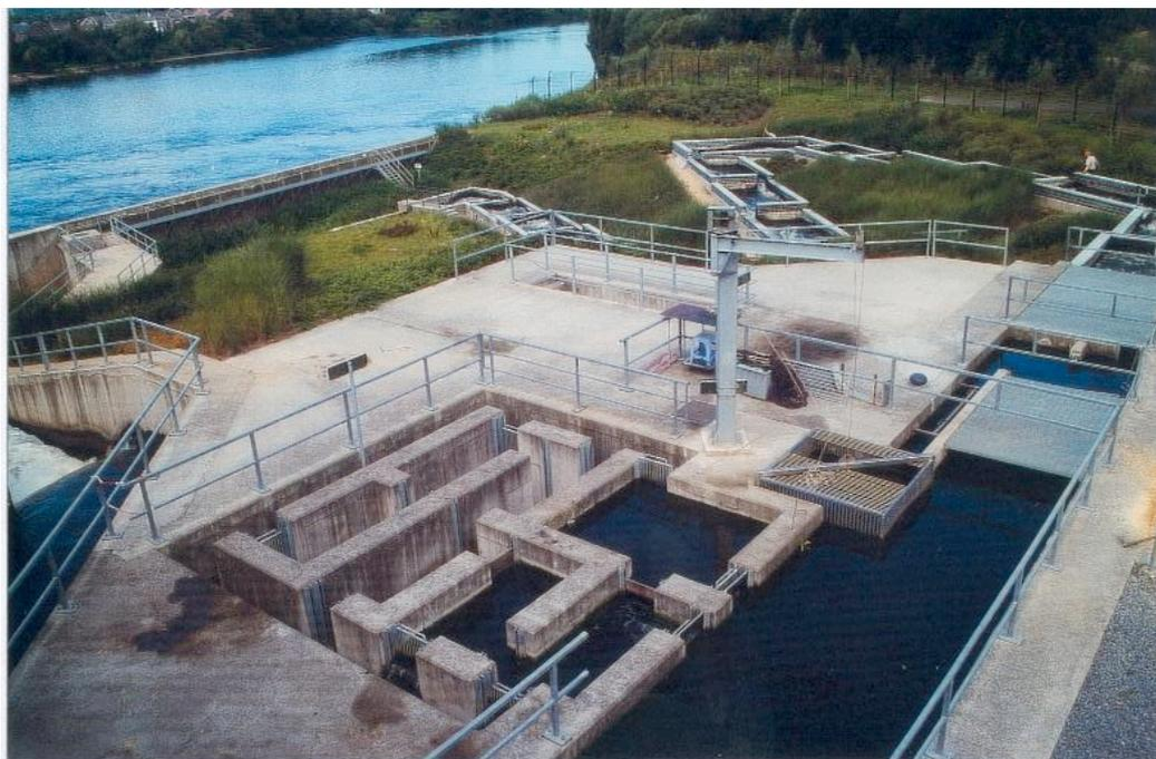
Photo 41. Nouvelle échelle à poissons (MET) sur la Meuse au barrage de Lixhe.
