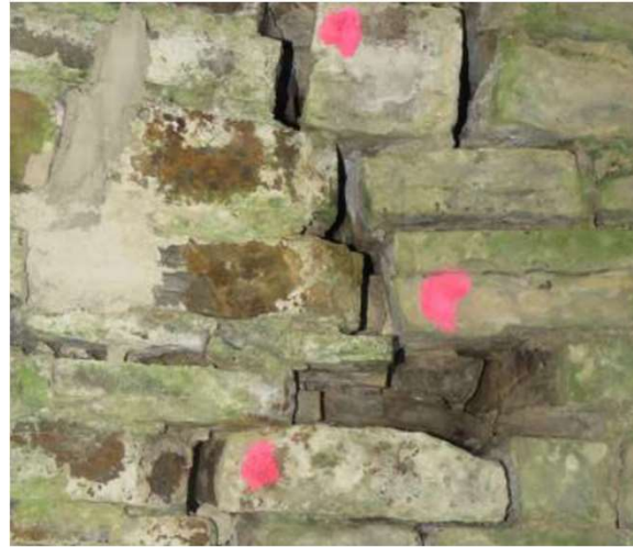
Détection des cavités au pont de Royen © Thierry Petit
