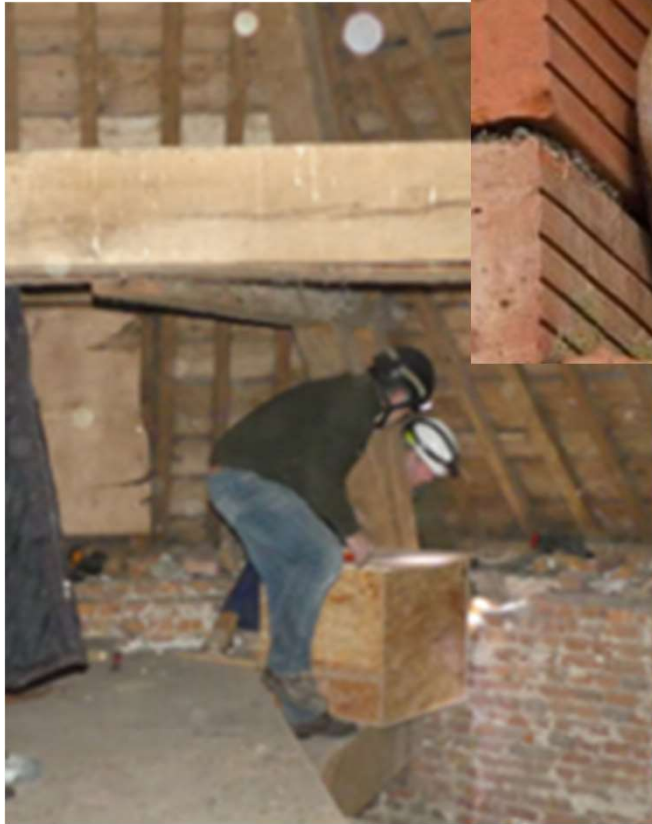
Installation d'un nichoir pour Chouettes effraies à l'église de Braine-le-Château.
