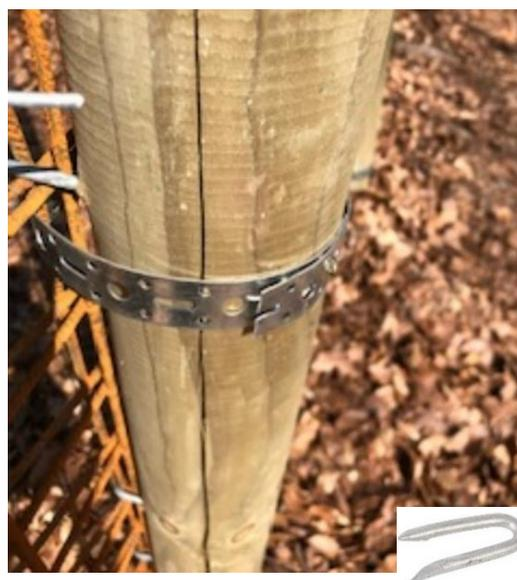
Figure 5 – Fixation du panneau au piquet à l'aide de clous cavaliers et de bande perforée
