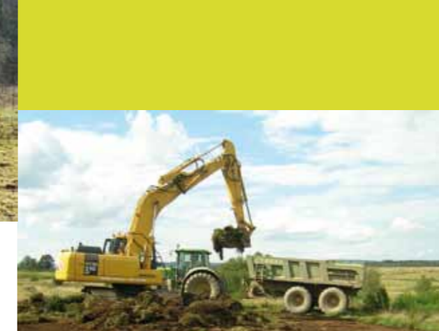
Etrépage pour restaurer une lande
