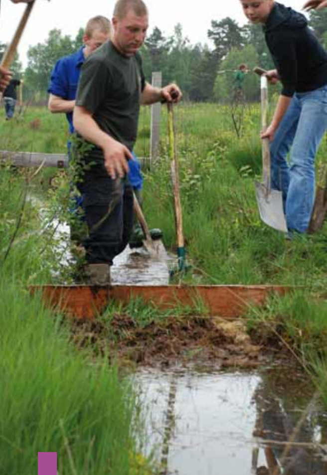
Bouchage de drains
