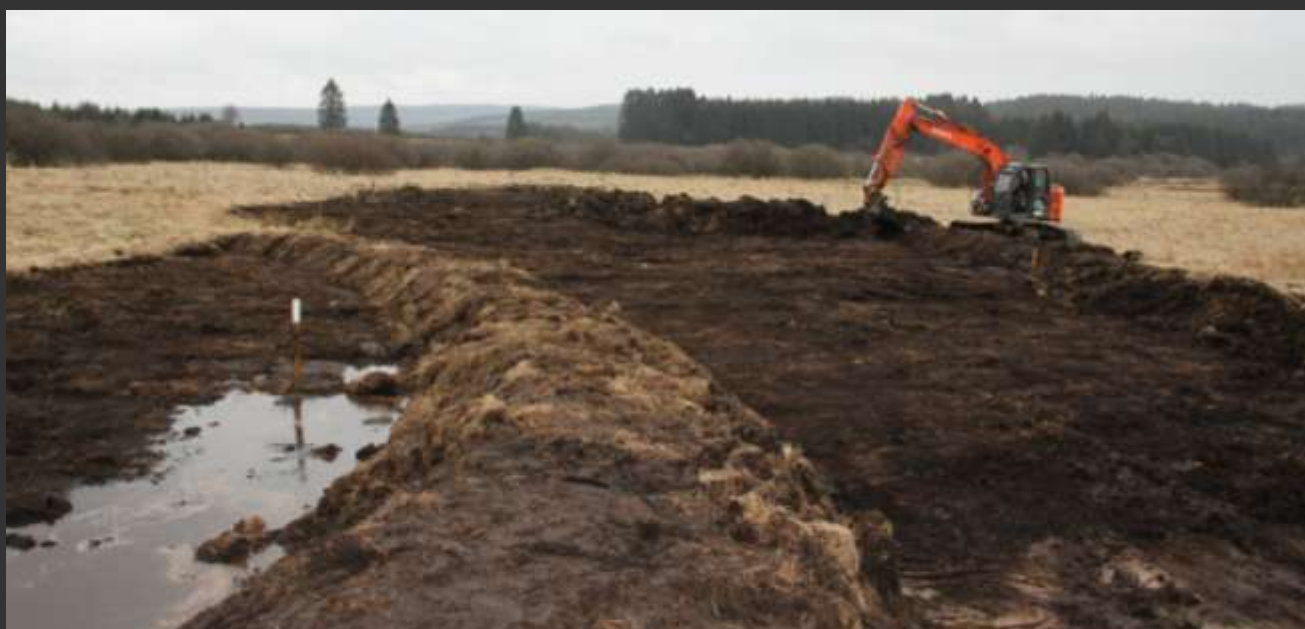
Etrépage en cours à la Réserve naturelle des Troufferies de Libin
