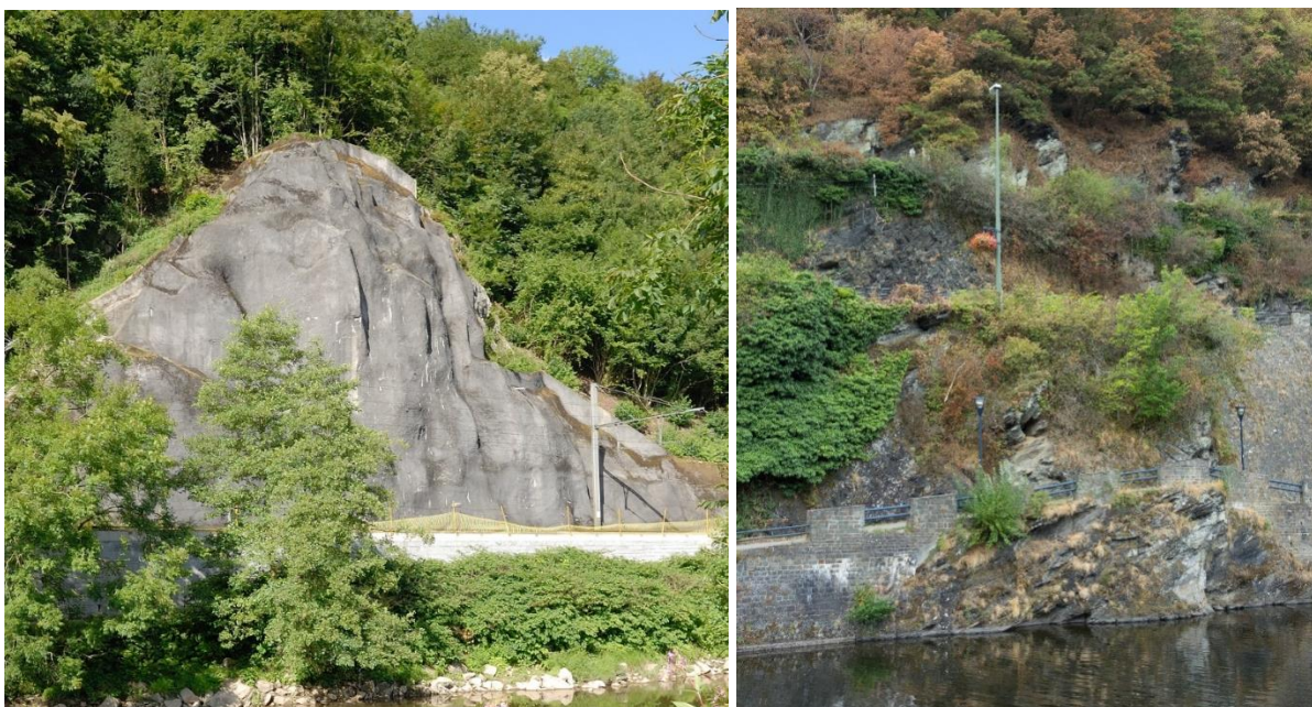
Destruction d'une paroi par gunitage le long d'une voie ferrée (à gauche). Dégradation d'un rocher naturel par le réseau routier (à droite). Photo g. J.-L. Gathoye - dr. L. Wibail
