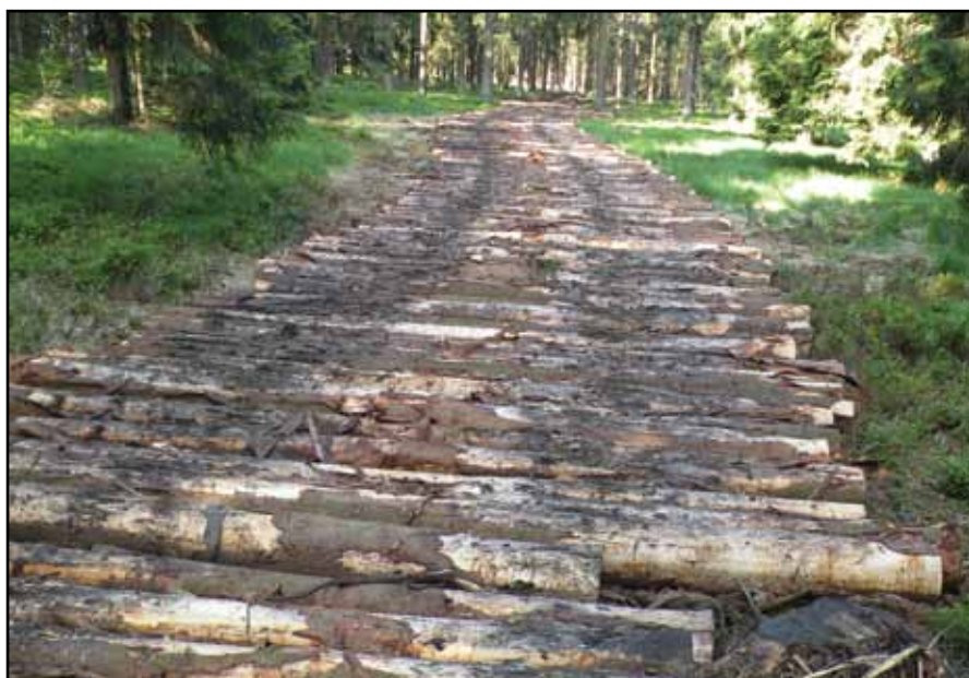
Layon de débardage constitué de billons d'épicéas.
