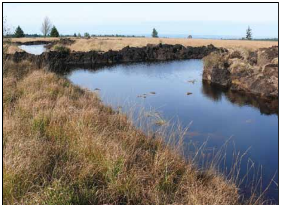
Barrages pour ralentir l'écoulement dans le Fossé Bouvy. (Photo R. Herman, octobre 2009).
