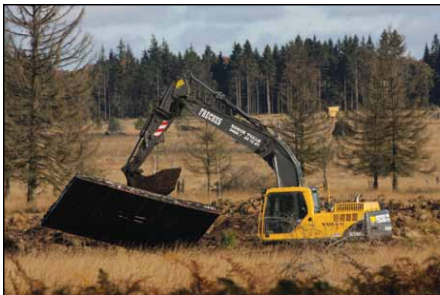
Des entrepreneurs disposent désormais d'engins spécialement adaptés pour opérer sur sol tourbeux, notamment grâce à l'utilisation de plateaux pour se déplacer. (Photo R. Herman, octobre 2010).
