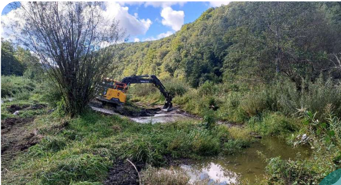
Remise en état d'une frayère située en amont du pont de claies à Vresse-sur-Semois en septembre 2024.
