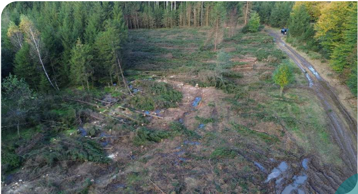
Chantiers d'abattage dans la commune de Bouillon, dans le cadre de la FA11 - ©PNVS
