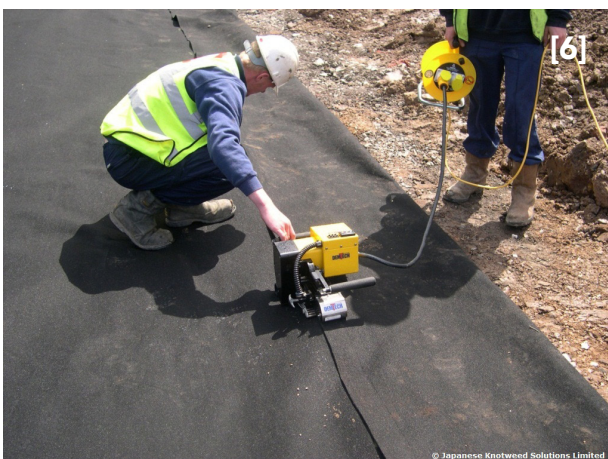
Enfouissement de terres contaminées par des rhizomes de renouées asiatiques dans une cellule de confinement
