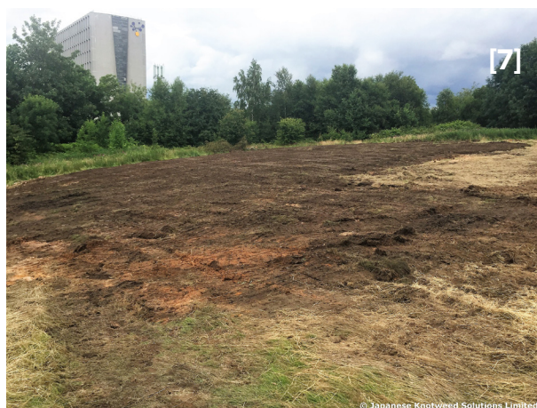
Enfouissement de terres contaminées par des rhizomes de renouées asiatiques dans une cellule de confinement
