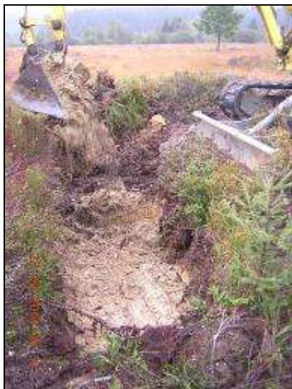
Bouchage du drain avec de l'argile
