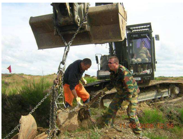
Utilisation de l'excavatrice
