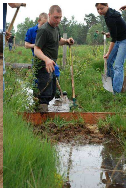
Utilisation de panneau hydrofuge
