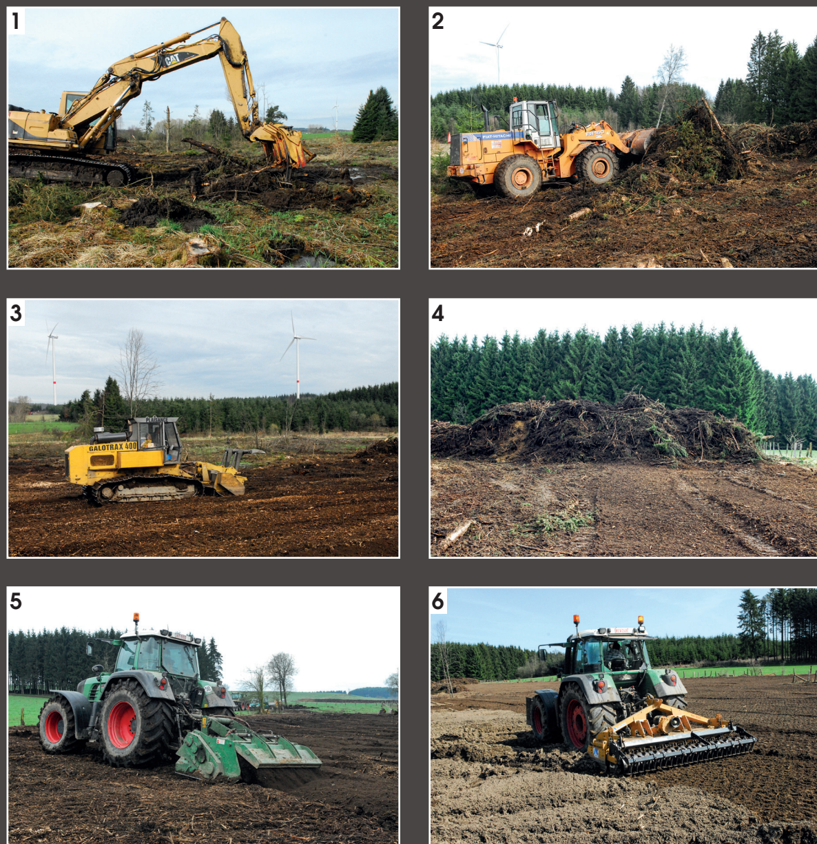
Figure 12 - Restauration de prairies humides par coupe de plantations d'écéas et nettoyage du sol. Débardage des branches avec une pelleteuse à grappin (1), andainage des branches et des souches avec un bulldozer (2), broyage des souches et des débris ligneux avec une déchiqueteuse forestière (3), andainage des bois qui peuvent ensuite être broyés pour réduire leur volume (4), gyrobroyage du sol (5), aplanissement du sol avec une herse avant le semis des graines ou le transfert du foin (6), pour permettre la fauche ultérieure. Source : Patrick Lighezzolo.
