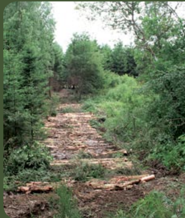
∴ Sur les sols les plus humides, le passage des engins d'exploitation se fait sur billons de bois
