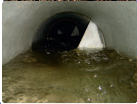
Vue interne du tuyau escalier mis sous eau
